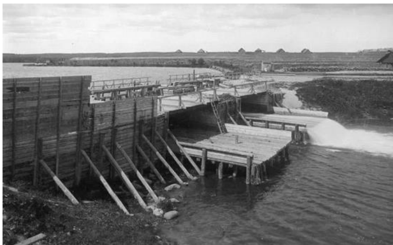
Строительство плотины для будущего завода
