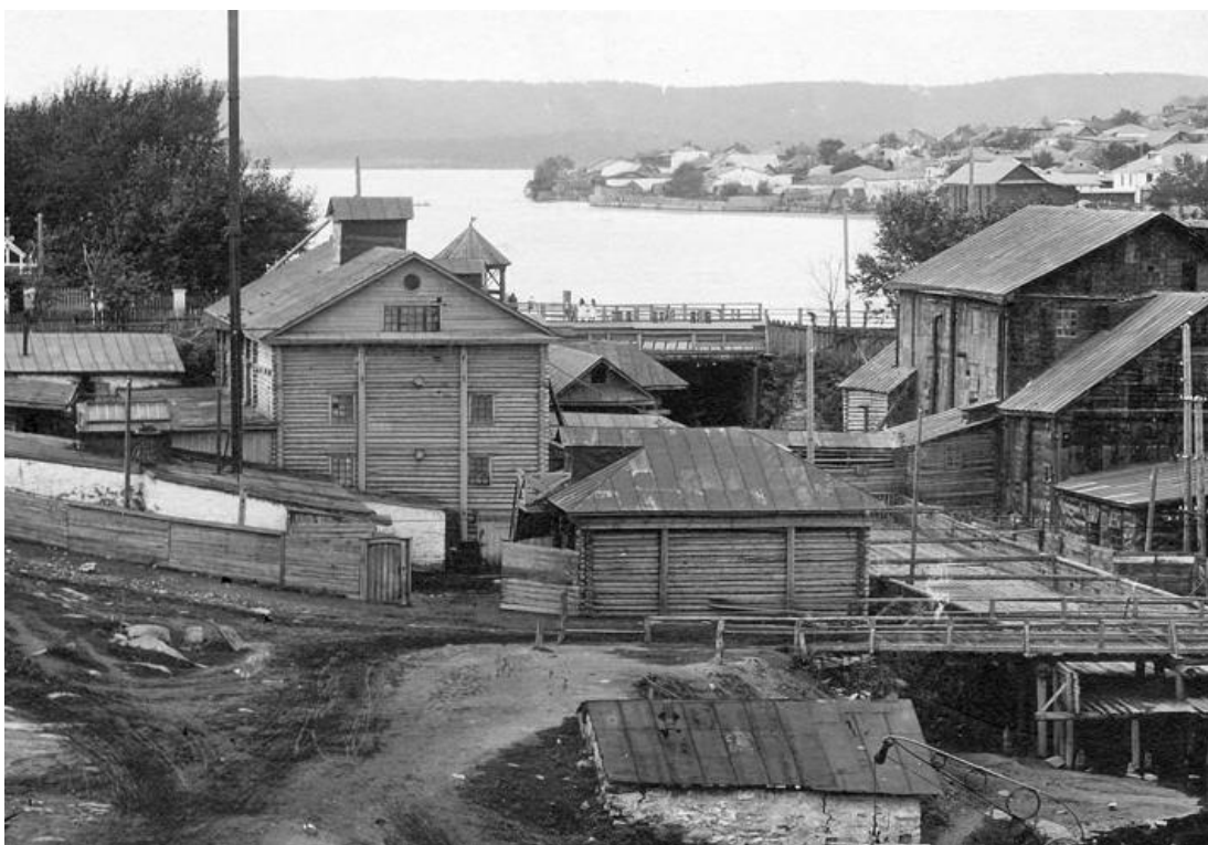
Вид на плотину со стороны реки Миасс. Фото с сайта https://zavodfoto.livejournal.com/2509686.html?view=comments
