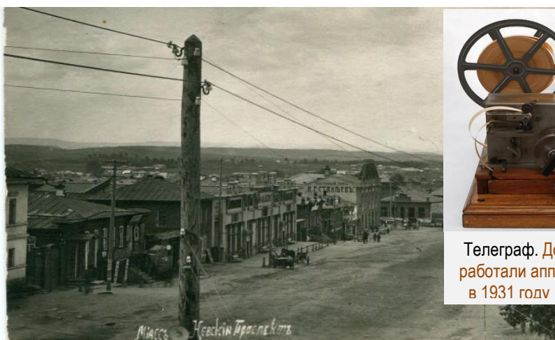
Телеграфные столбы — Воздушная линия электропередач в Миассе
