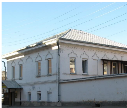
Дом купца Кислякова, ул. Свердлова, 5. 2008 год.
