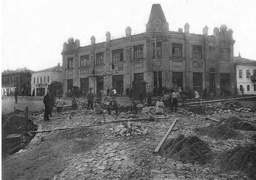
Мощение дороги перед ТД Стахеева на развилке Невского проспекта и Златоустовского тракта
