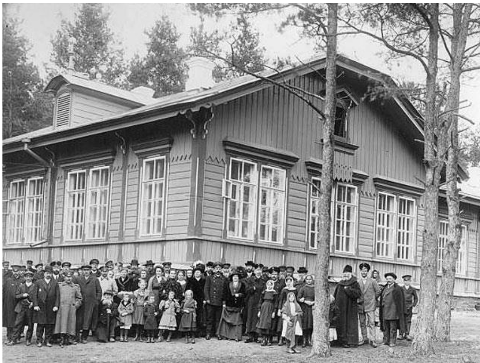
Миасская земская больница (ныне Городская больница им. Маврицкого). Старый город, напротив Свято-Троицкой церкви. Фото 1905-1916гг. Автор неизвестен Фото с сайта: https://foto-history.livejournal.com/15463856.html?ysclid=lfqkkriyh505766581
