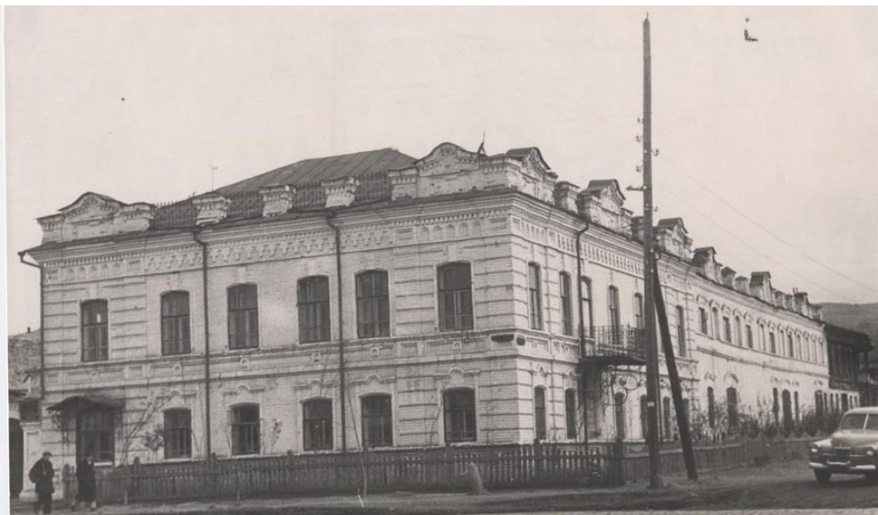
Дом купца Важдяева, где разместился Миасский горно-металлургический техникум. Фото с сайта История Миасса из окна рейсового автобуса https://2018.miasskiy.ru/istoriya-miassa-za-oknom-reisovogo-avtobusa/?vsclid=loc3fvwb4a991949686
