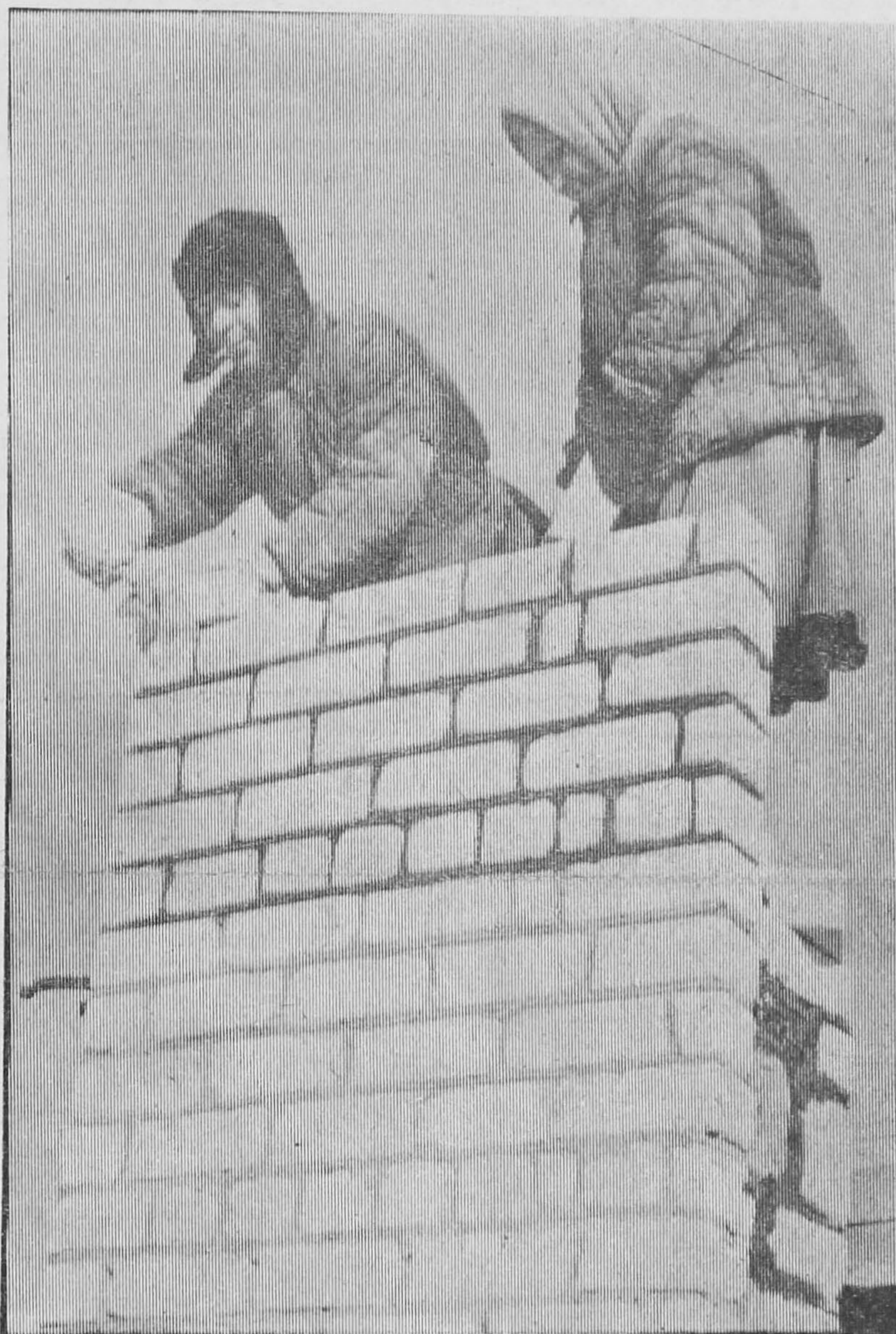
В ЮЖНОМ поселке строители треста «Уралавтострой» заложили фундаменты новых многоквартирных жилых домов. На доме № 52 трудится бригада каменщиков 4-го района, возглавляемая тов. Шершневым. Коллектив возводит стены первого этажа 36-квартирного дома. Особенно хорошо работает передовая каменщик бригады В. Колодкин с помощницей М. Кочетковой. Идя навстречу 90-летию со дня рождения В. И. Ленина, они ежедневно перевыполняют задания на 70—80 процентов.
