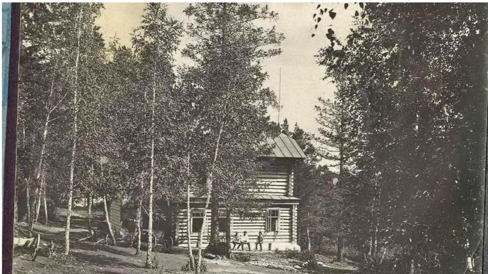
Дом № 1 на базе Заповедника, Канцелярия, квартира для директора, наблюдателя (лесника) и две комнаты для приезжающих. 1929 год. Фото с сайта https://vk.com/wall-97118488?ysclid=lgge4yyag5799285732&z=photo-97118488_457241507%2Fwall-97118488_4569
