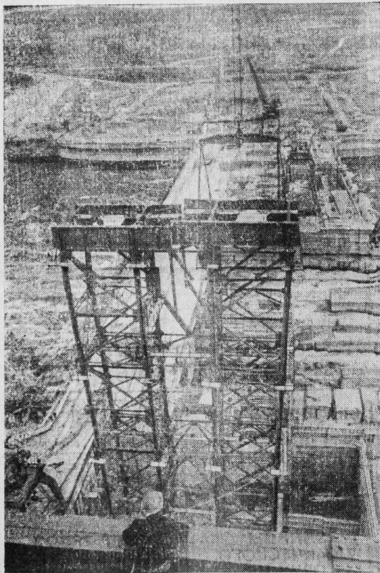
ИРКУТСКАЯ ОБЛАСТЬ. Полным ходом идет строительство Усть-Илимской ГЭС. Ведется подготовка к бетонированию плотины и фундамента под здание станции, монтируется большая бетоновозная эстакада, готовится к пуску второй, более мощный бетонный завод. С его пуском еще шире развернутся работы на сооружении энергетического гиганта.
