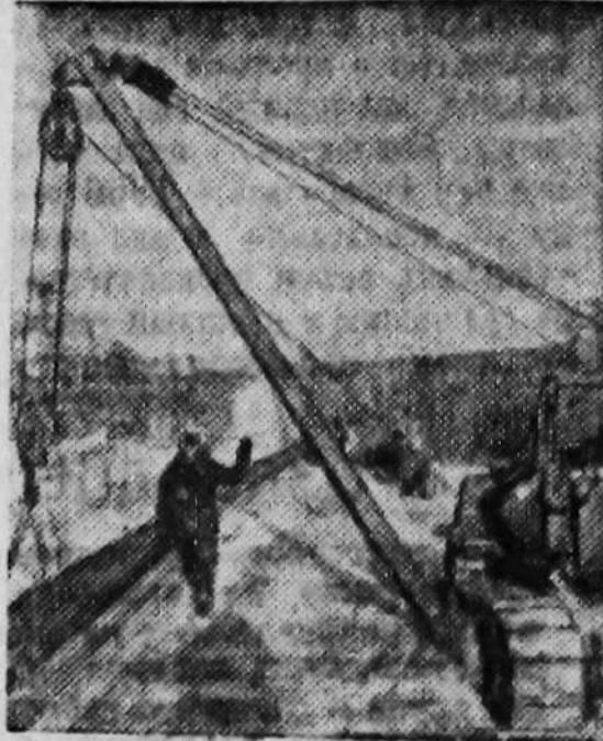
в ближайшее время ввести в строй еще 14 километров нефтепровода
